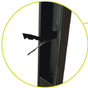
Marco de acero con garras de anclaje
